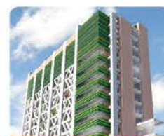
Edif. Nuevo en Construcción
